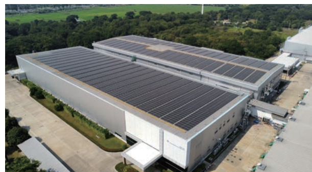
タイ芝浦電子シンブリ工場の太陽光パネル
